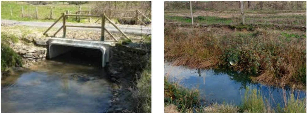
Figure 10 : Exemples de dalot et de canalisation
